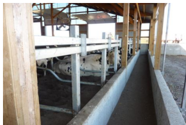
Figur 3 De sætter en ny sokkel uden for den gamle, dermed bliver der plads til køernes rejse-sig bevægelse.
