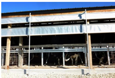
Figur 4 De nye stolper monteres på den nye sokkel og udhængets yderste kant. Det nye gardin monteres på den nye sokkel og de nye stolper.
