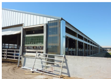
Figur 5 Når stalden bliver 0,5-1,0 meter bredere i begge sider, forandres gavlenes udseende lidt. Her er der sat en klar plade på i begge sider.
