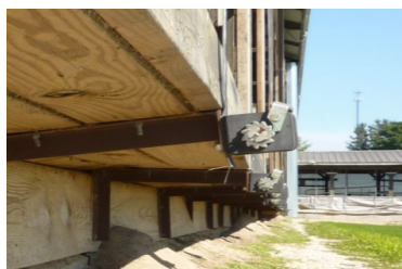
Figur 8 De fastgør vinkeljern på soklen, så stalden bliver bredere med udbygning af en repos i træ. For enden af vinkeljernene fastgøres gardin-styret.
